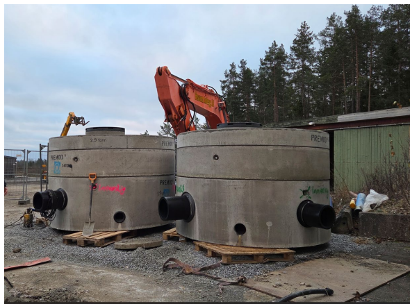
Montering av 2 stk vannkummer
