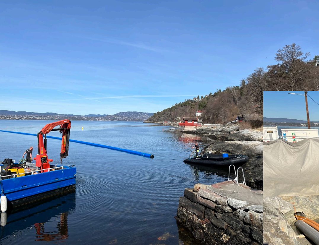
Inntrekking av PE-rør i borehull
