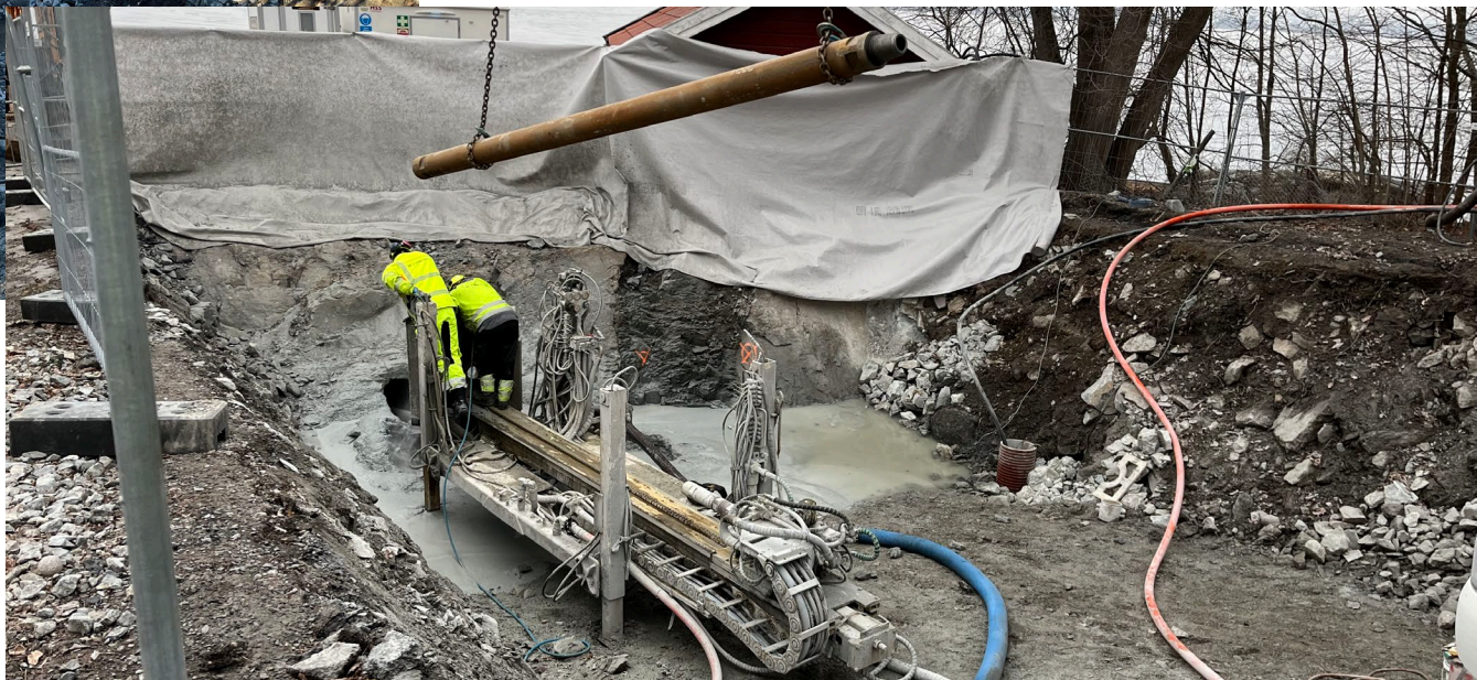
Boring under Flaskebekk brygge
