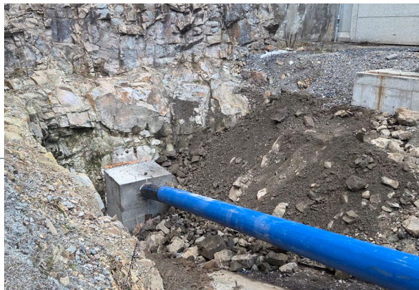
Forankring av ledning
