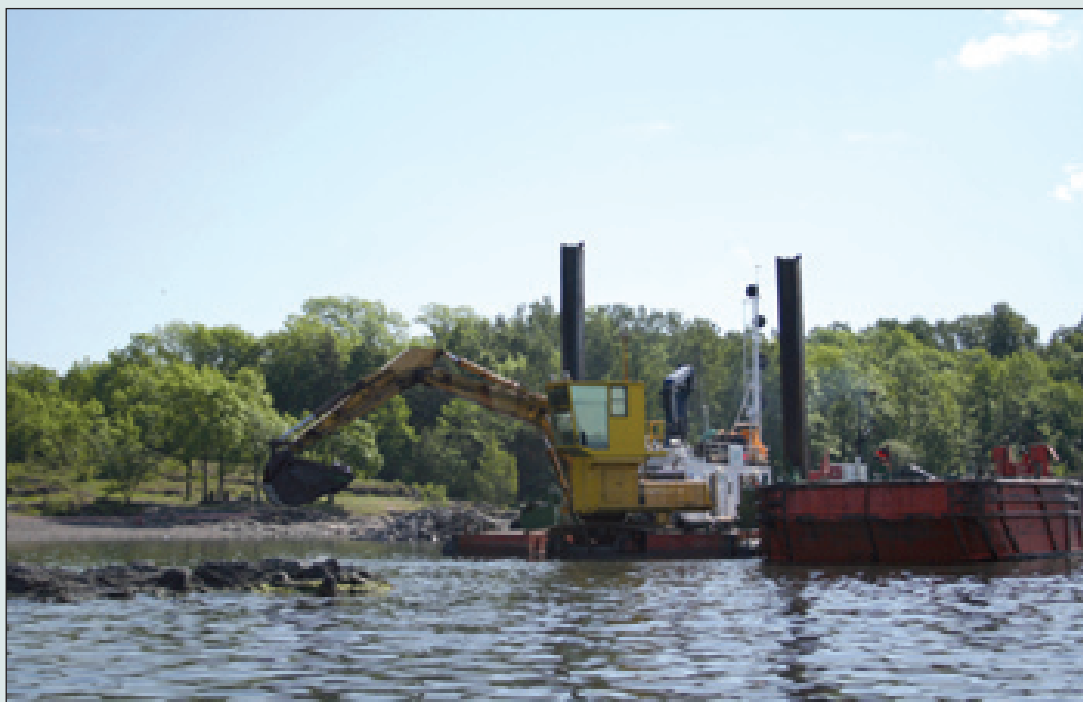
Mudring av badestranden på Hovedøya, stranden ble etterpå tildekket med sand. Arbeidene ble utført på forsommeren 2007.
