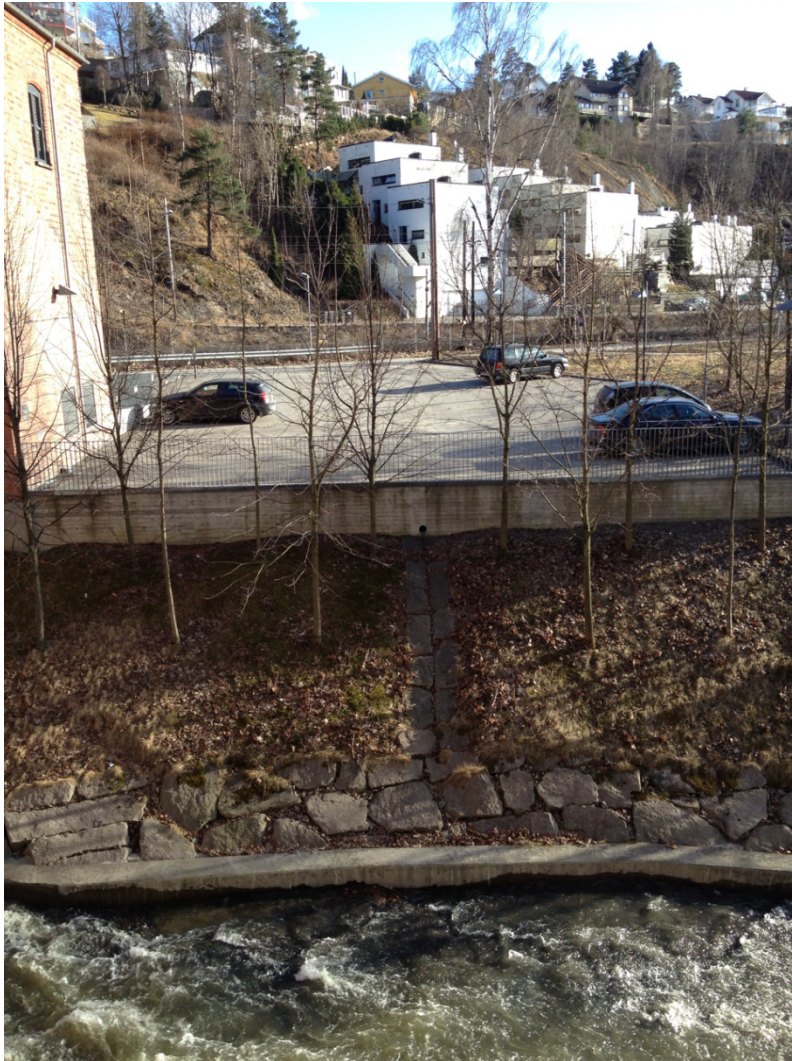
Figur 4. Parkeringsplass med kum som drenerer rett til Alna
