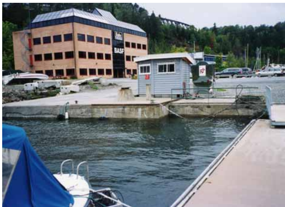
Bilde 4.4a Mottaksstasjon i Leangbukta i Asker
