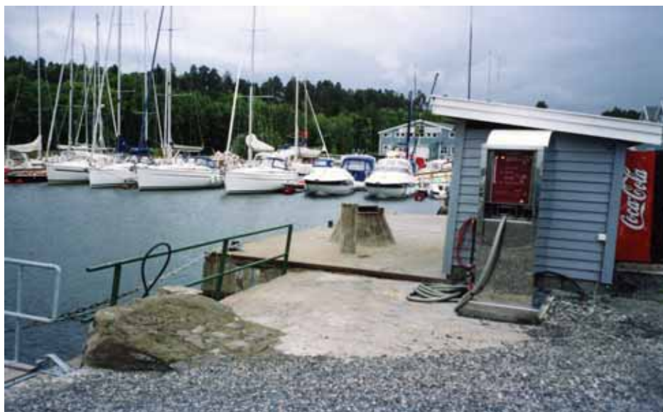
Bilde 4.4b Adkomsten til mottaksstasjonen i Leangbukta
