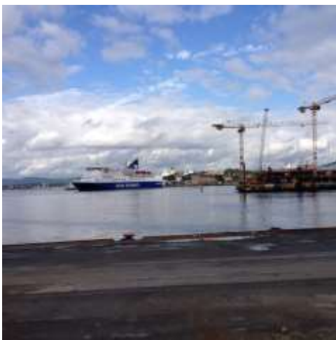
Figur 24. Oslo havn. Vippetangen midt i bilde og Sørenga med kraner til høyre.
